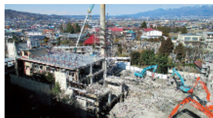
③ 2015年11月～2016年4月 旧精神科東病棟・旧北病棟解体
