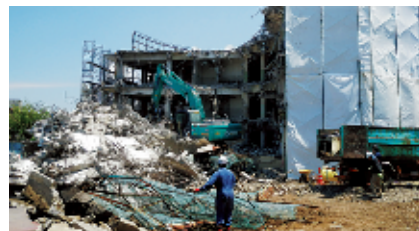
② 2014年4月～8月 旧精神科西病棟（丸ビル）解体
