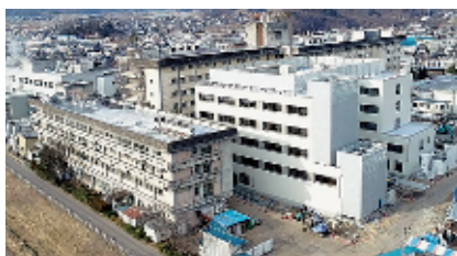
⑥ 2017年3月 北病棟（新病棟）竣工
