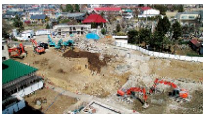
④ 2015年11月～2016年4月 旧精神科東病棟・旧北病棟解体
