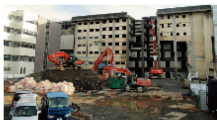
⑦ 2017年10月～2018年8月 本院7階建て東西病棟解体
