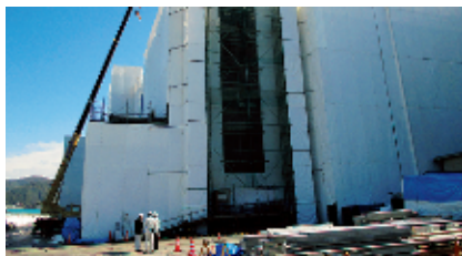
⑤ 2016年5月～2017年3月 北病棟（新病棟）建設
