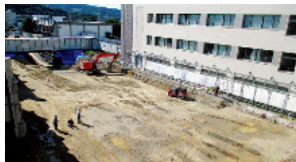
⑧ 2017年10月～2018年8月 本院7階建て東西病棟解体
