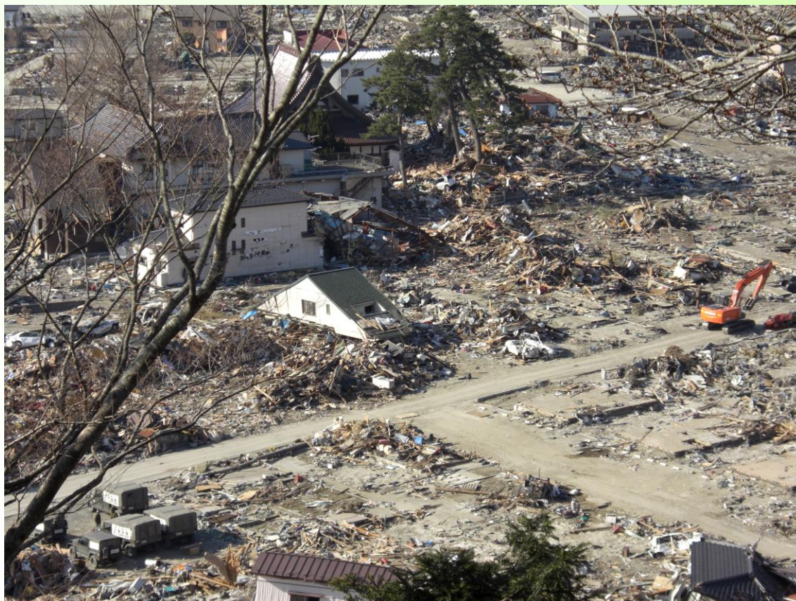
石巻市内（日和山公園より）瓦礫除去風景
